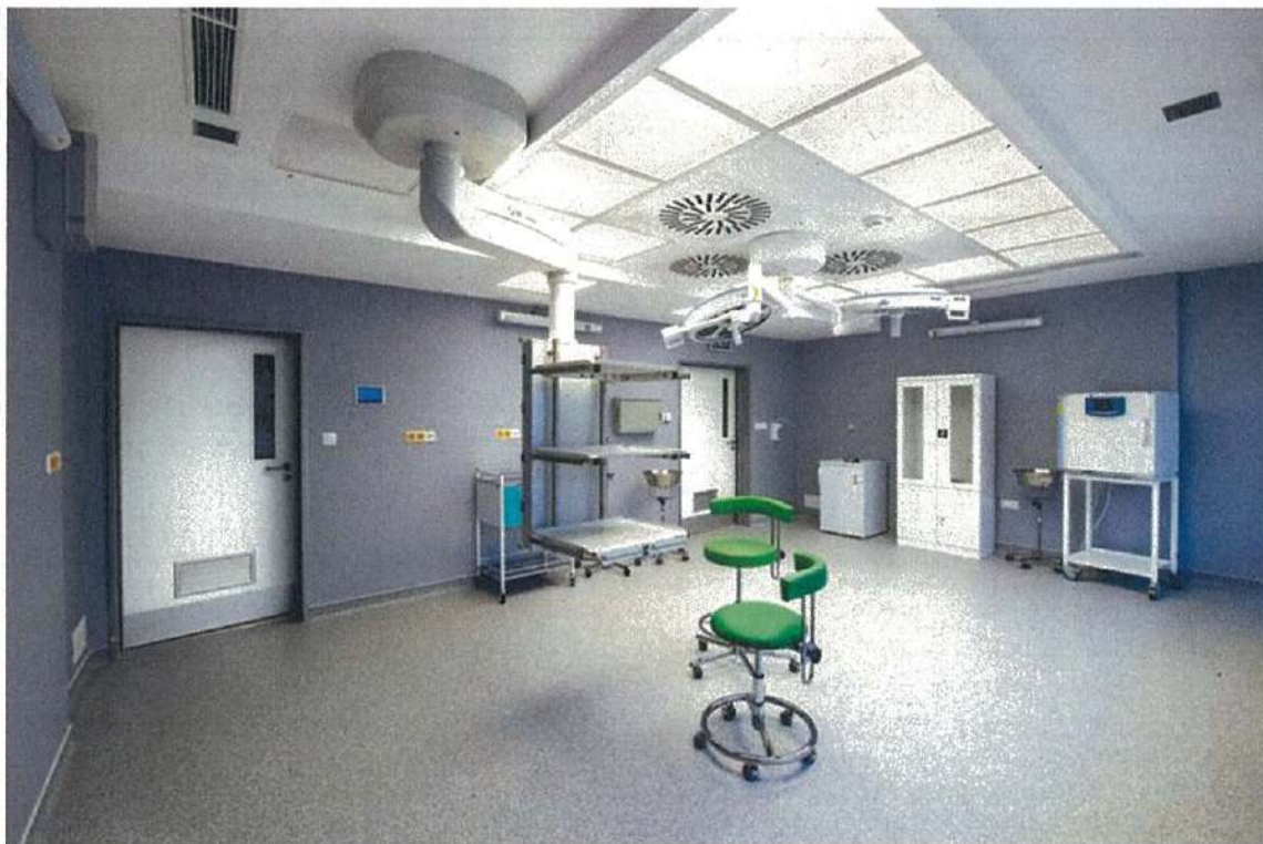
Rekonštrukcia urgentného príjmu Galanta
