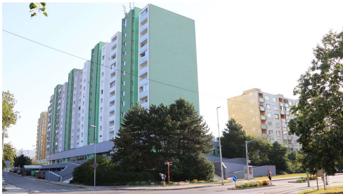
Obrázok 1 - Obnova panelového bytového domu
