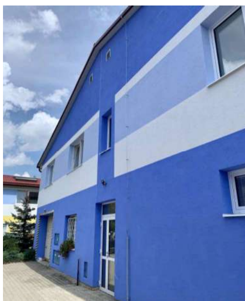
Hala po rekonštrukcii.
