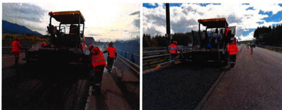
Obr. 4, 5 – Opravy na D1, Mengusovce
