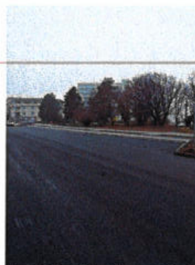
Obr. 21 Trenčín, Zlatovská ulica
