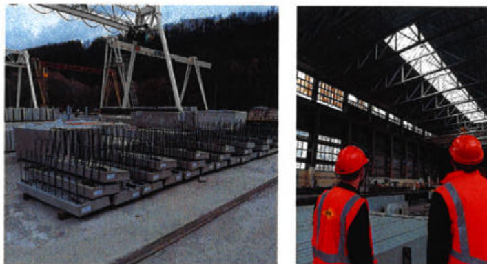
Obr. 8, 9 - Prefa Kysak – výroba železobetónových prefabrikovaných konštrukcií
