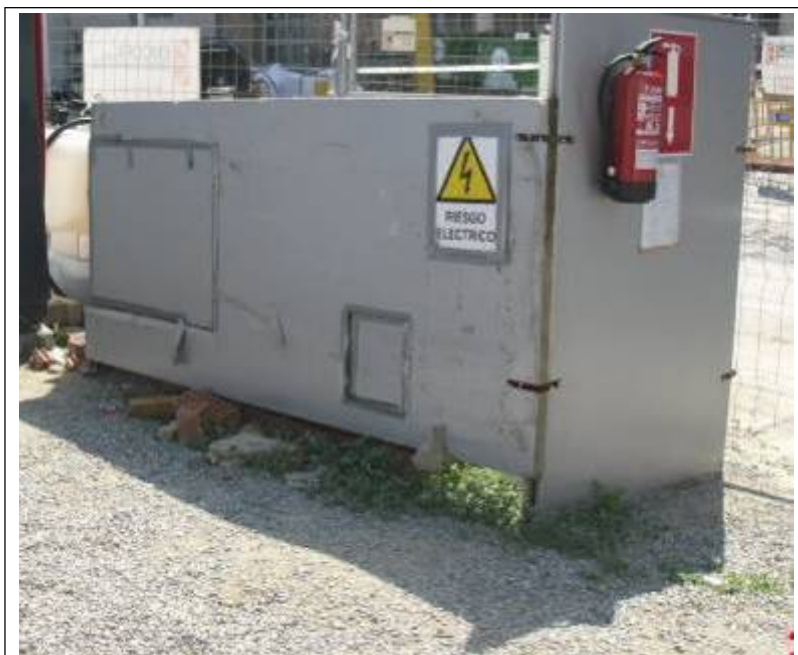
Obrázok 5.39: Zvukovo izolovaný generátor elektrickej energie
